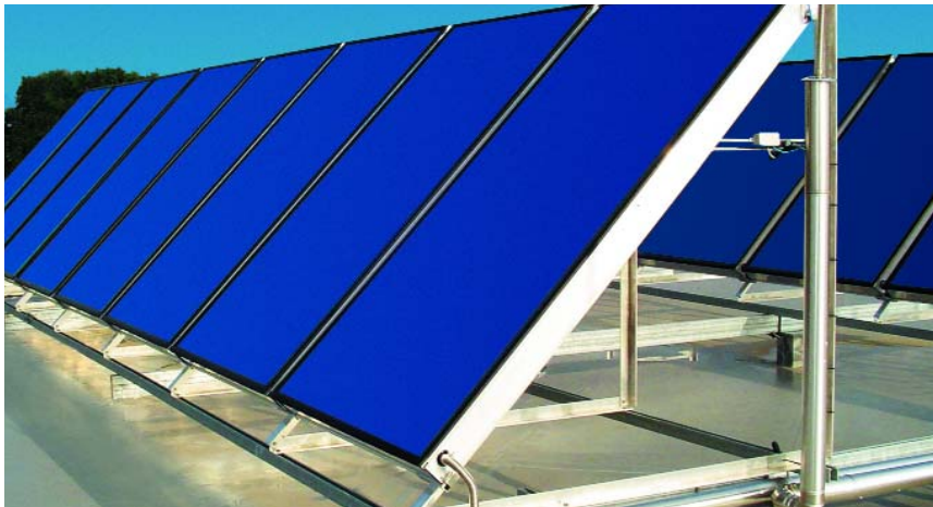
16 solfangere monteret på fladt tag
