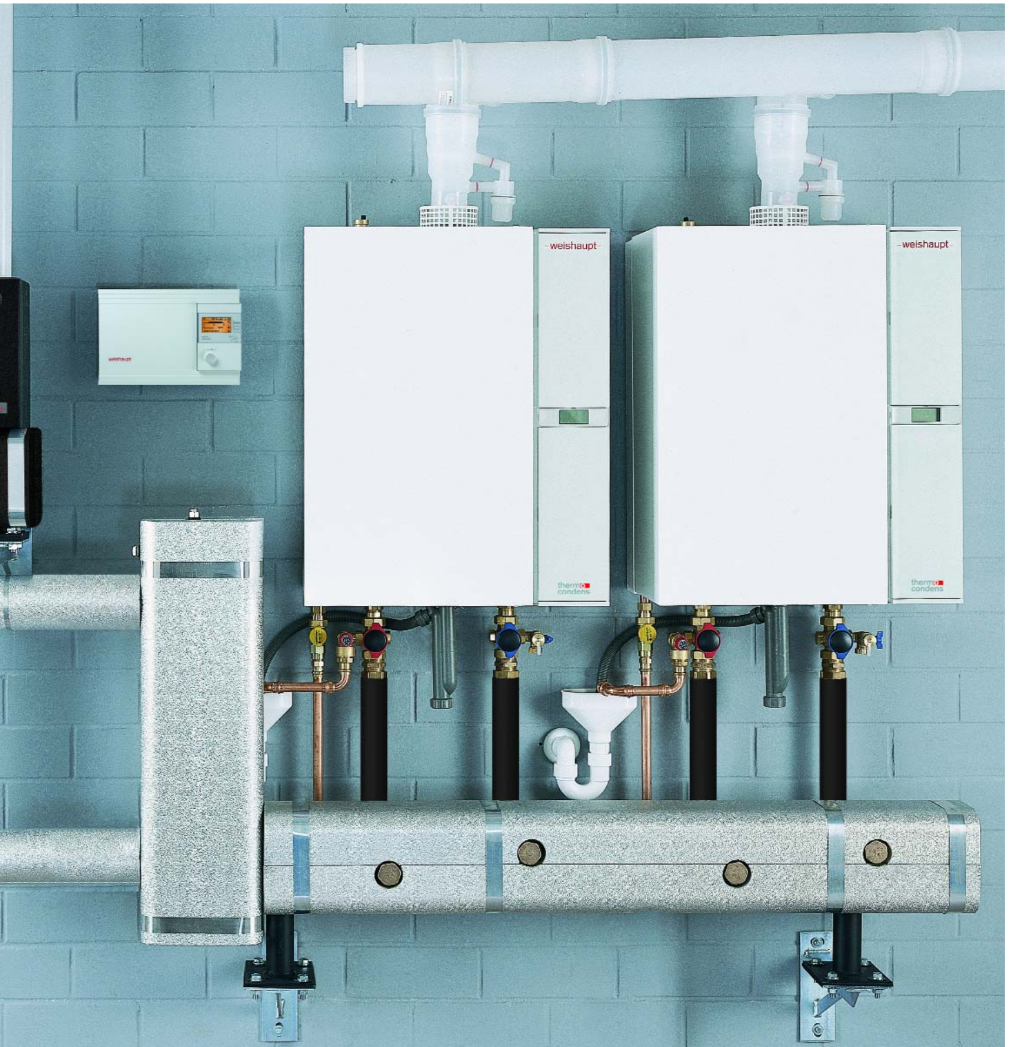
Med en Thermo Condens kaskade på f.eks 300 kW starter modulations-mindste ydelse på 5%, den kan efter behov trinløst øges op til 100% ydelse
